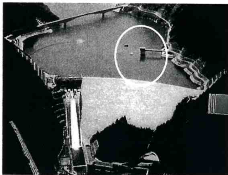
設置例(阿木川ダム全景)
