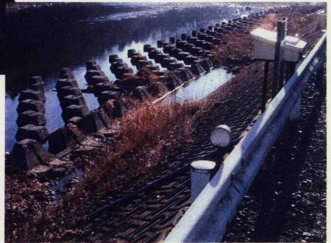
河川水位連続観測地点の橋
