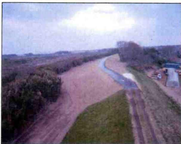
築堤の施工完了状況（平成20年 3月完成） 〔常総市中三坂地先〕
