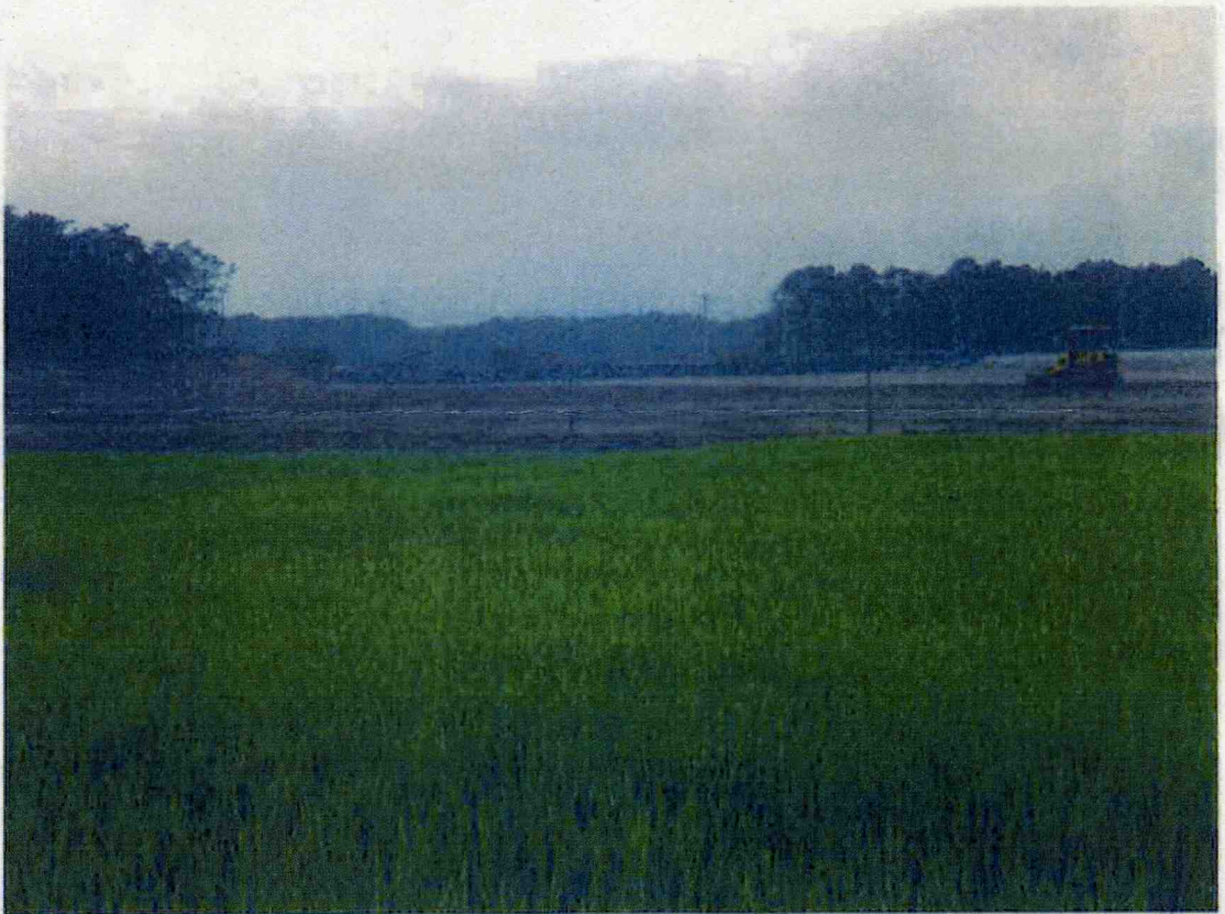
[土囊設置完了全景]
