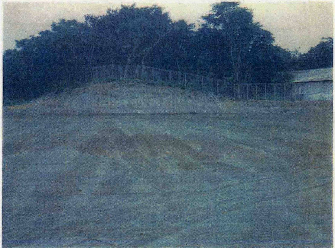
[丘陵部掘削状況]
