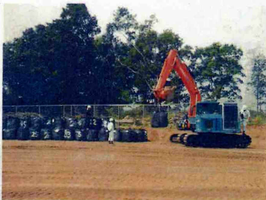
[若宮戸地区 大型土嚢設置状況]
