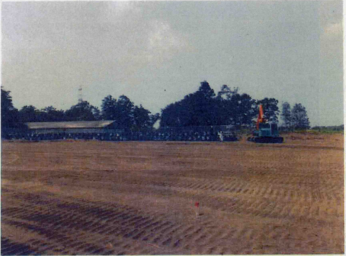
[土囊設置作業状況]
