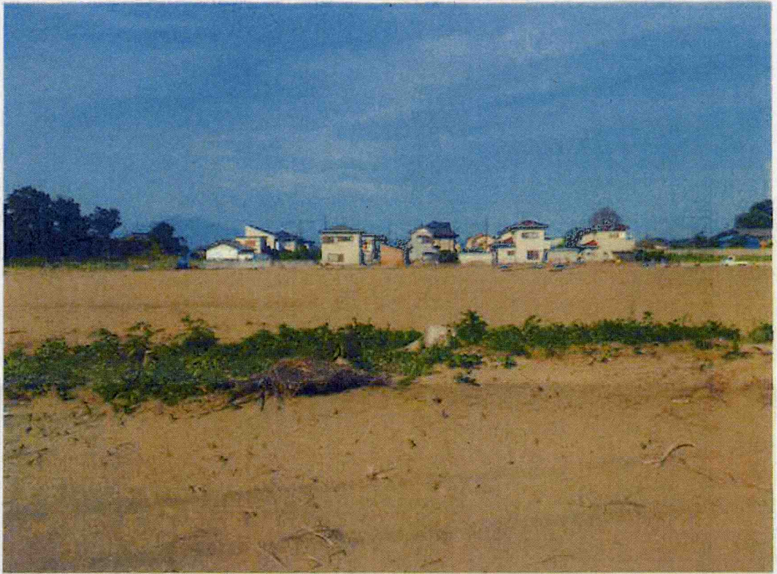
[太陽光発電事業地整地状況]
