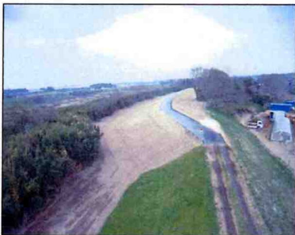
築堤の施工完了状況（平成20年 3月完成） 〔常総市中三坂地先〕
